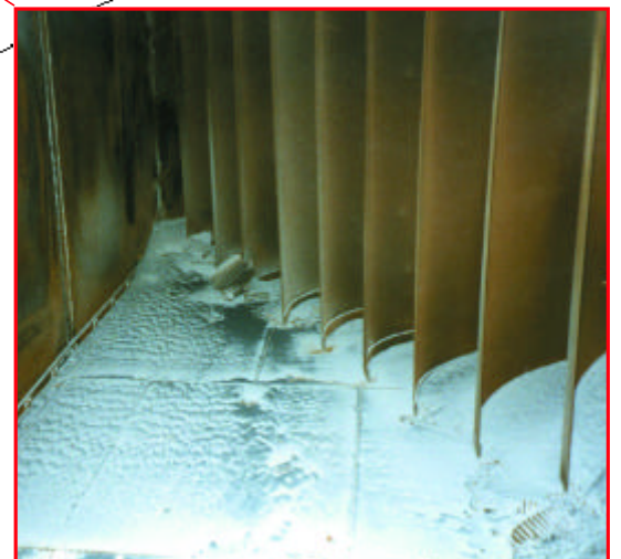
微粒子を含んだ煙道ガスによる飛散灰の蓄積と、それに伴う腐食を最小限に抑えるため、CFD解析では、ESPマニホールドのバンドおよび回転羽根の再設計に重点が置かれた。
