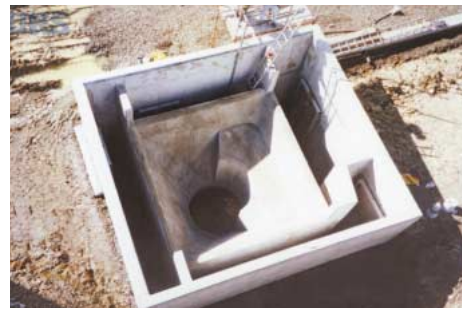
施工前に設計変更されたスプリッター
