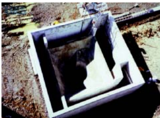
施工前に設計変更されたスプリッター
